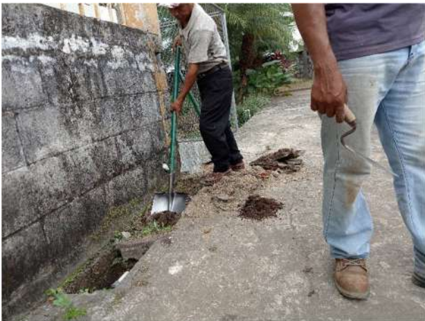
Figura 90 y 91. Cambio de llave de paso central.
