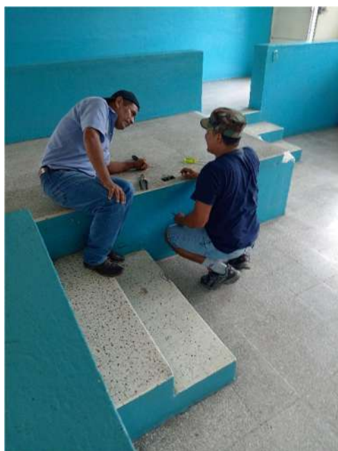
Figura 88. Se arregló e instaló la tierra física para el resguardo de los equipos.
