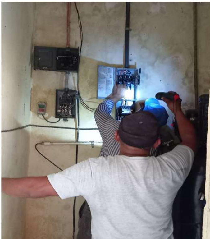
Figura 86. Reparaciones eléctricas de la caja del compresor.
