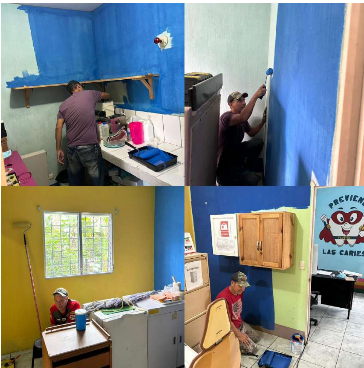
Set de fotografías 3. Cambio de pintura interior.
