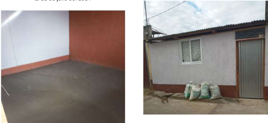
Fotografía 4. Remodelación final de la habitación de la familia Senté Chile, Santo Domingo Xenacoj (2da calle, 1-46 zona) Periodo del 1 de octubre al 15 noviembre 2023 -15 de enero al 31 de julio del 2024
