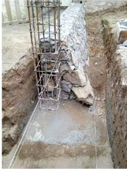
*Cimiento corrido de concreto armado más sobrecimiento de piedra caliza con acero de refuerzo*
