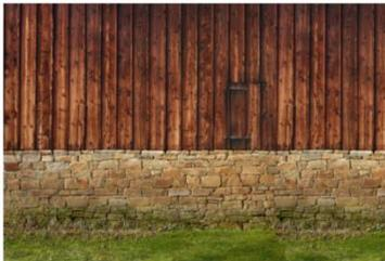
*Muro bajo en piedra caliza más muro de madera curada con aceite usado de uso automotriz*
