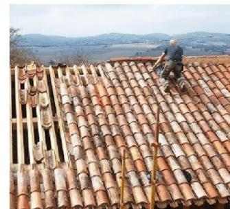
*Estructura de madera más cubierta de teja de barro cocido*
