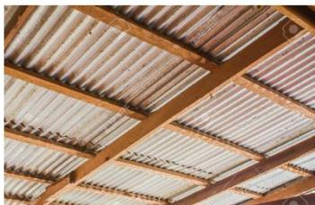
*Estructura portante en madera curada con aceite usado automotriz más lamina galvanizada*
