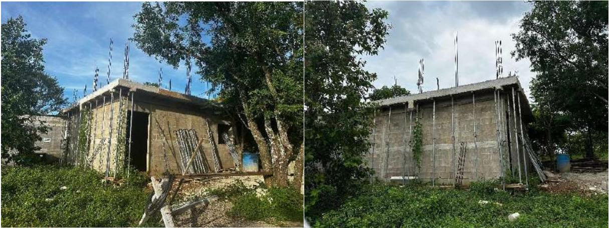
**Imagen 12.** Fundición de terraza para planificación de segundo nivel. Concluyó obra gris.
