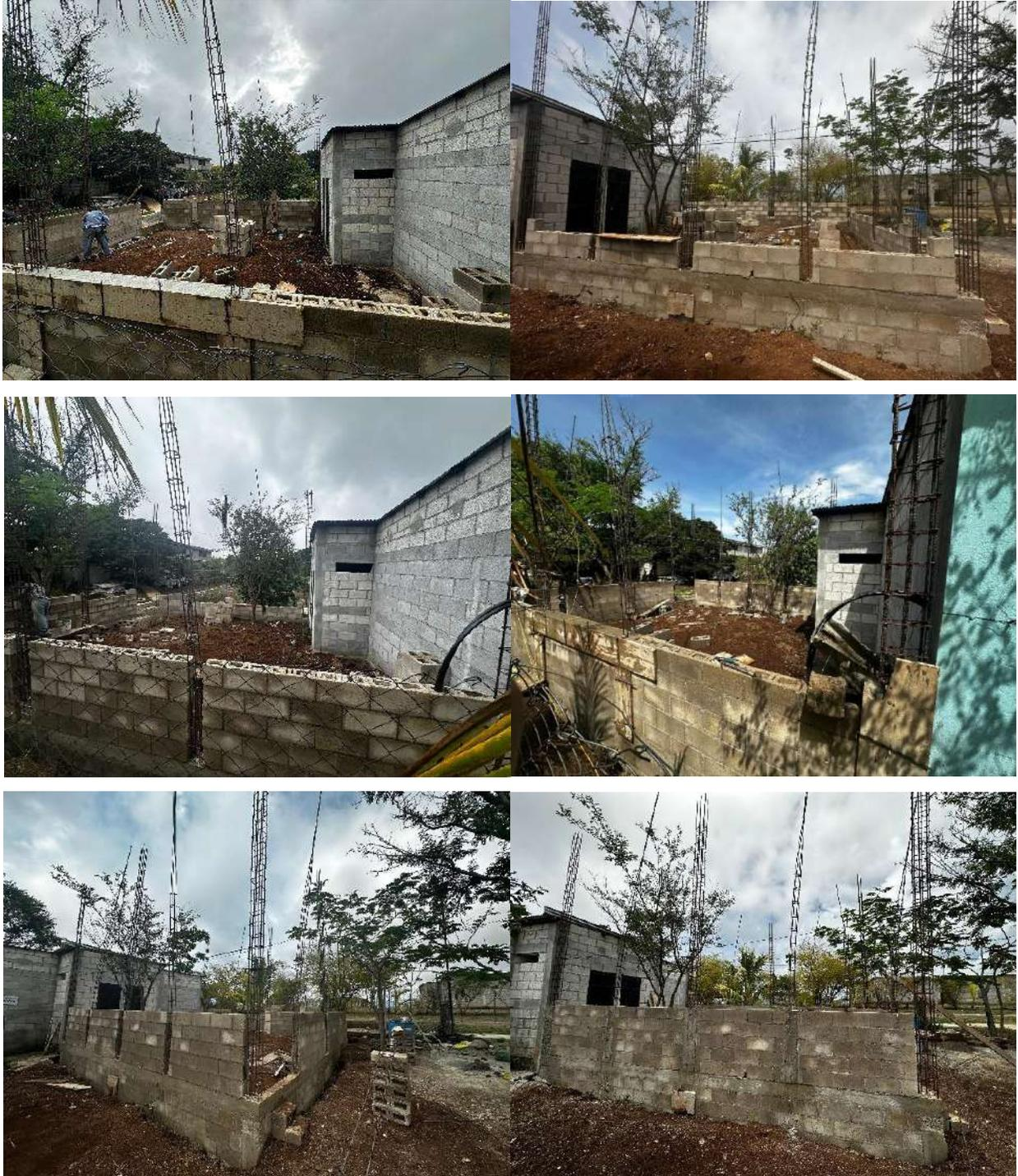
**Imagen 9.** Levantamiento de paredes con block.
