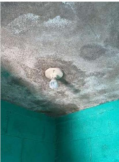
Imagen 3. Filtración de agua en el techo del baño de maestras.
