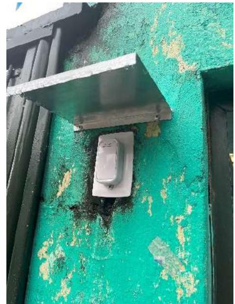
Imagen 8. Timbre inalámbrico para exteriores instalado en la puerta de la escuela con techo de lata para protección de sol y lluvia.
