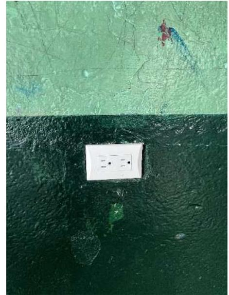
Imagen 10. Tomacorriente instalado correctamente, disminuyendo el riesgo de accidentes.
