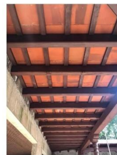
Estructura cubierta Terraza Española
