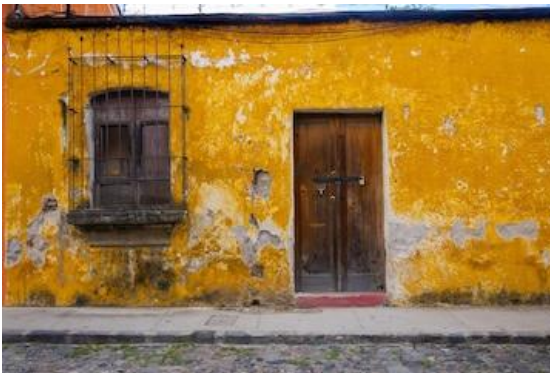
Figura 12 – Detalle puerta y ventana colonial Fuente: https://es.wallapop.com/item/casa-centrica-175-1057413356
