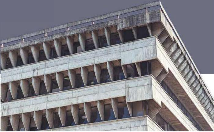
**Figura No. 48:** Módulo de parteluces de concreto expuesto fachada sur del edificio INFOM. Fotografía por Ricardo Bonilla, año 2024.
