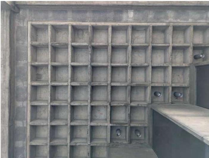
**Figura No. 47:** Estructura de losa nervurada de concreto expuesto vista desde el primer nivel. Fotografía por Ricardo Bonilla, año 2024.
