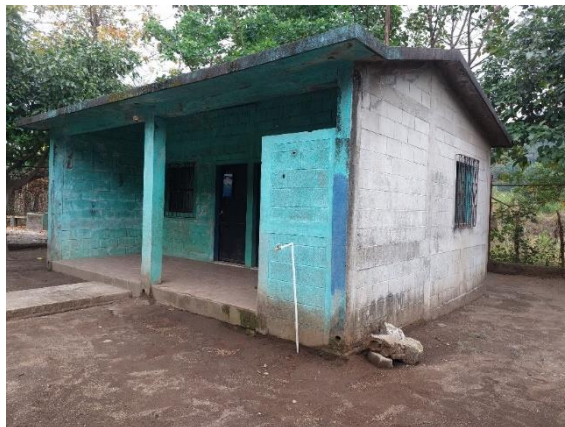
Centro Comunitario de Santa Ana, ubicado en San Miguel Pochuta, Chimaltenango, antes de las remodelaciones.
