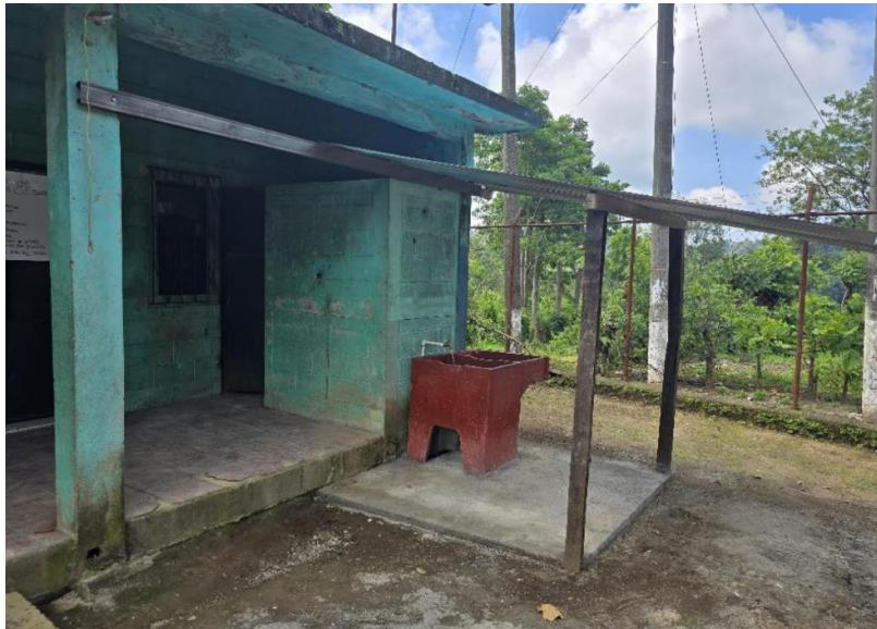
Colocación de pérgola para proteger la pila y al agua en su interior de lluvias y sol.
