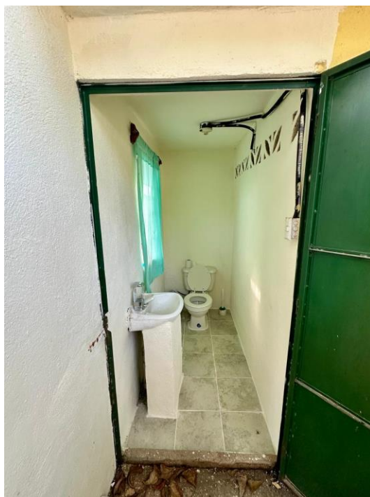
Fotografía No.11, vista frontal del baño.
