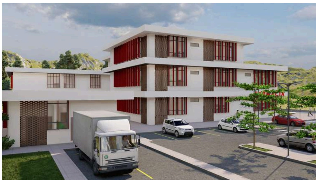
Figura 161, Vista exterior del Centro de Atención Integral Materno Infantil (CAIMI), San Agustín Acasaguastlán, El Progreso.
