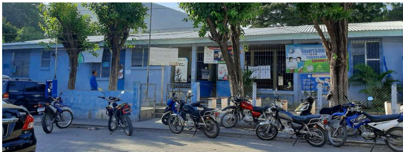
Figura 1, Fotografía estado actual del Centro de Salud, San Agustín Acasaguastlán, El Progreso
