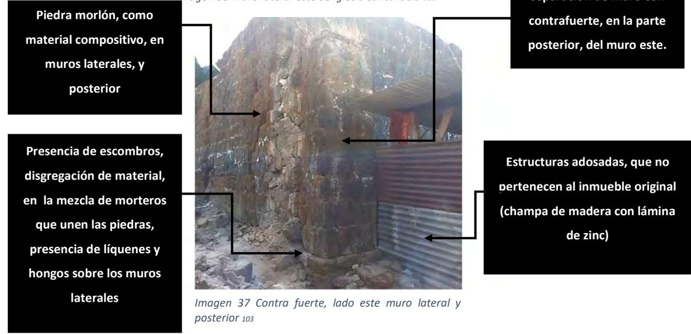
Imagen 37 Contra fuerte, lado este muro lateral y posterior <sup>103</sup>
