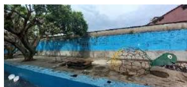
Imagen 1.4 de Mario García (Malacatán, San Marcos 2023). Archivos de Ejercicio Profesional Supervisado en Malacatán, San Marcos. Nota: Se observa el repello del socalo de la pared perimetral del área de juegos sin pintar.
