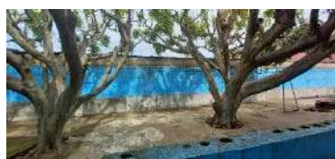
Imagen 1.2 de Mario García (Malacatán, San Marcos 2023). Archivos de Ejercicio Profesional Supervisado en Malacatán, San Marcos. Nota: Se observa el repello del socalo de la pared perimetral y árboles sin pintar.
