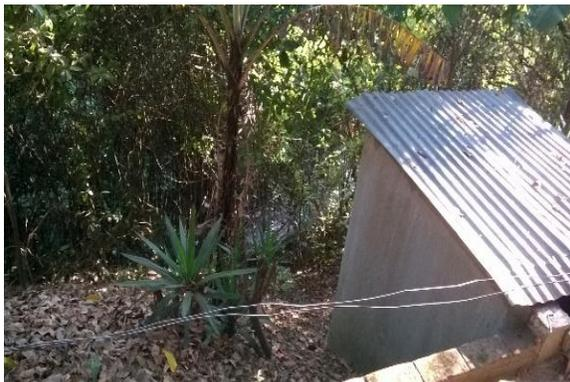
En el área del barranco, existen dos cajas, con el fin de recolectar agua de lluvia y sirven como elementos disipadores, evitando la erosión de terreno en el sector del barranco
