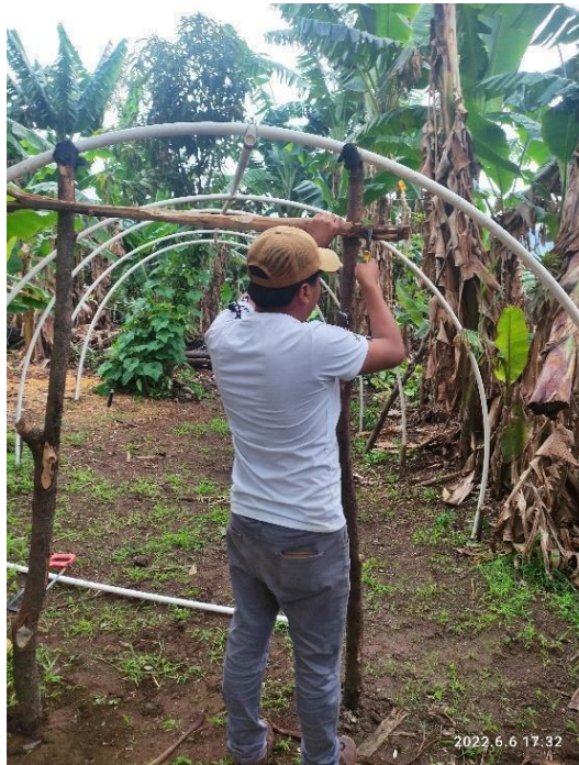
Figura 13: Construcción de macrotúnel. Fuente: Jonatán Menchú, (julio 2022).
