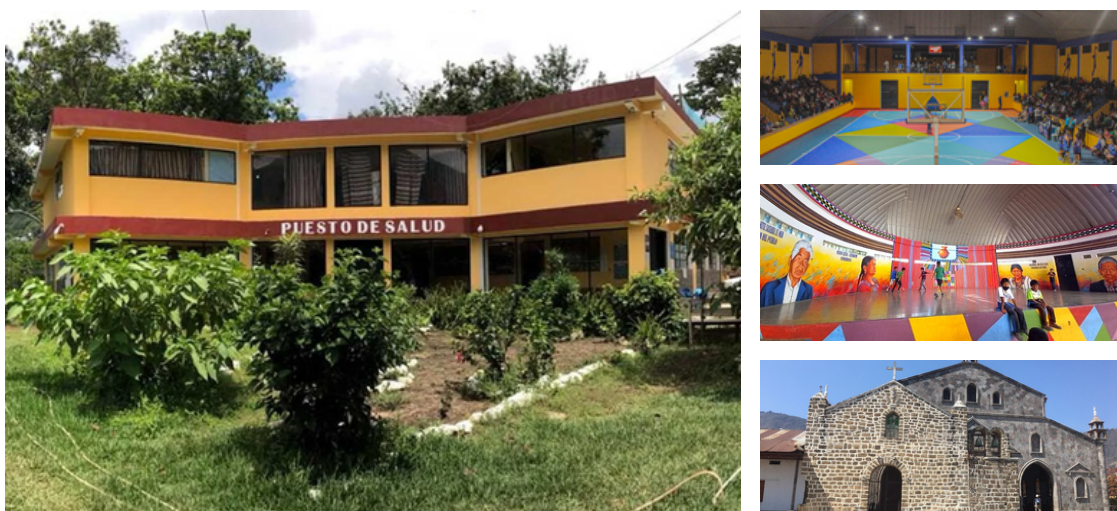
Figura 75: Equipamiento del municipio de San Juan La Laguna, Sololá
