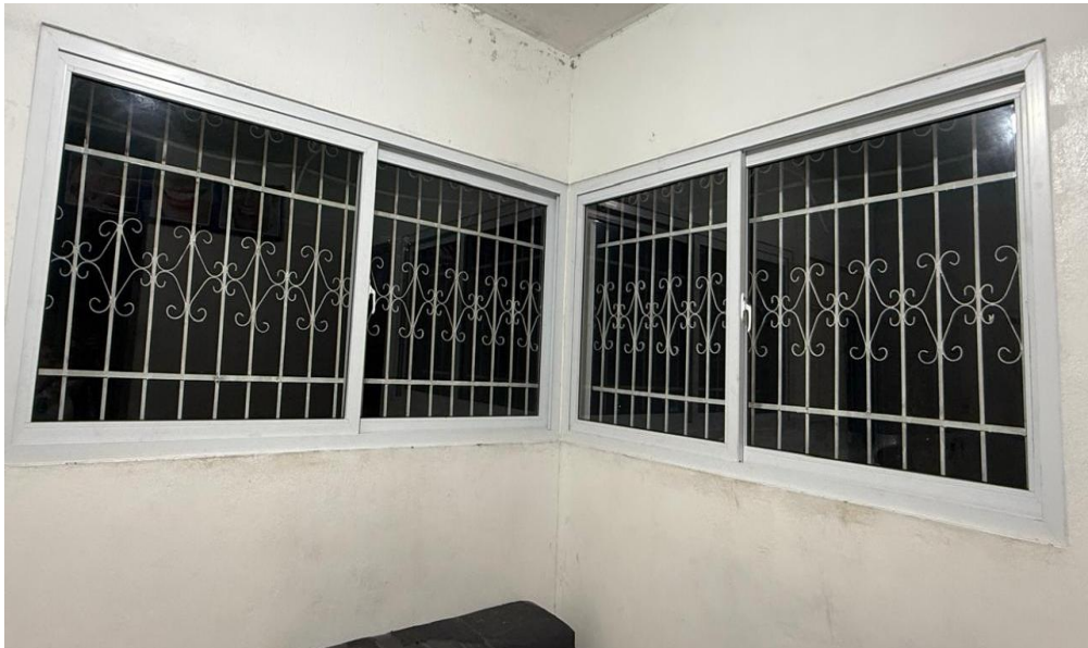
Foto 4. Parte de adentro de la sala de espera, ventanas instaladas.
