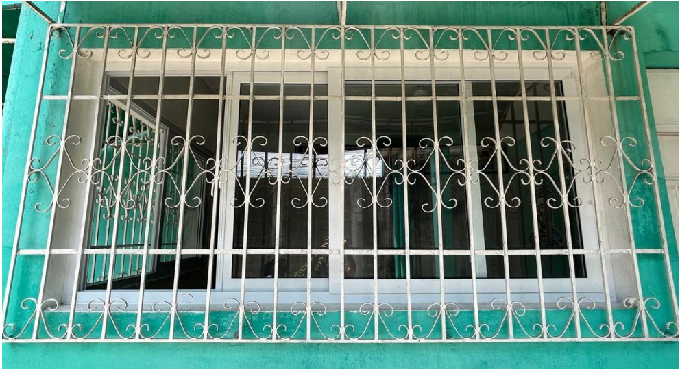
Foto 3. Ventana frontal de la sala de espera, ventanas instaladas.
