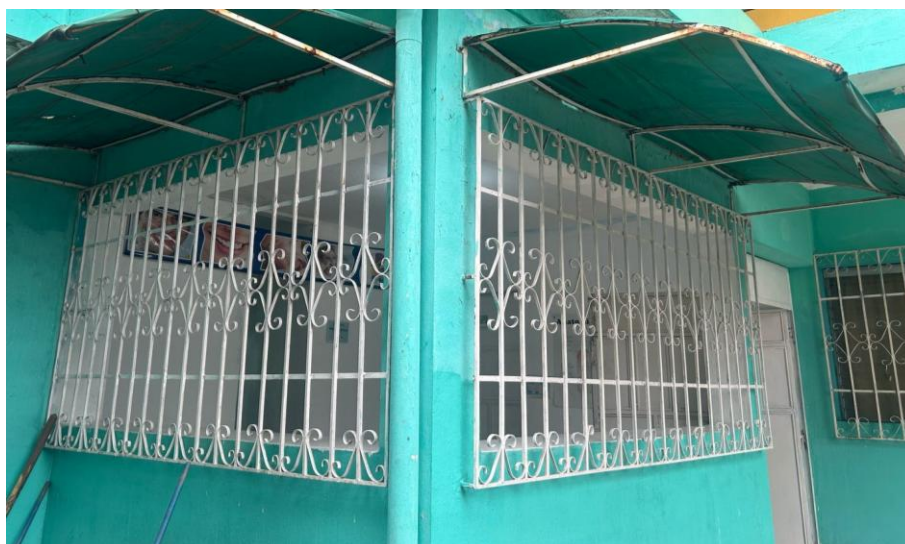
Foto 1 Vista frontal del área de espera antes de la intervención. Obsérvese la falta de ventilación natural y escasa iluminación (agosto 2024).
