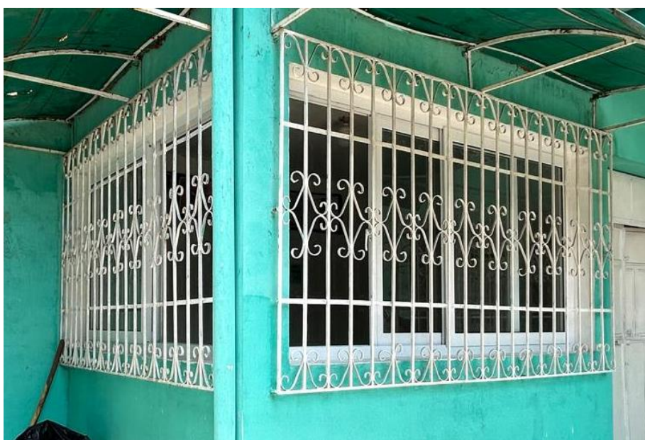
Foto 2. Ventanas instaladas en su fase final, mejorando la iluminación natural y ventilación del espacio (abril 2025).
