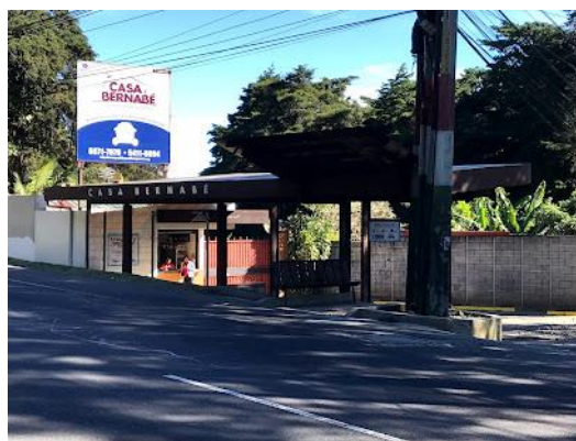
Imagen 18: Entrada principal de Fundaci1 n Casa Bernab°
