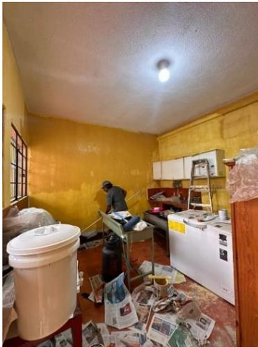
Imagen 6: Aplicación de primera capa de pintura de interior color amarillo.
