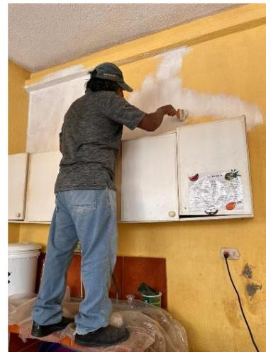
Imagen 5: Aplicación de primera capa de impermeabilizante en pared con problemas de humedad.
