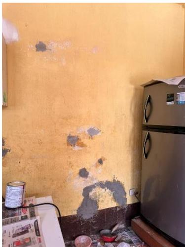
Imagen 4: proceso de paredes de limpieza y resanado de agujeros en la pared.
