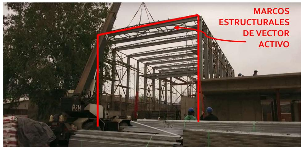
**Figura 34.** Instalación de marcos rígidos metálicos.
