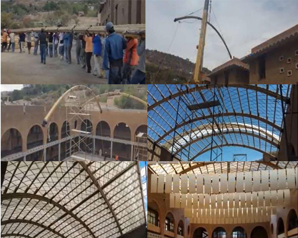
**Figura 71.** Proceso constructivo de la cubierta del patio central
