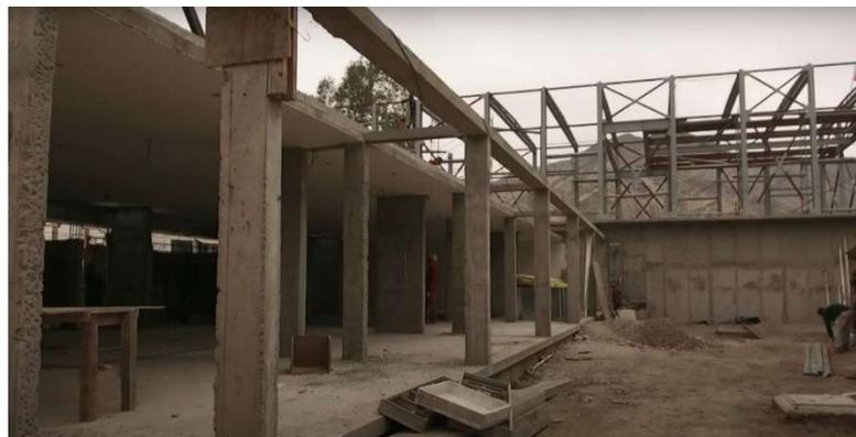
**Figura 32.** Estructura de concreto y acero sin recubrimientos.
