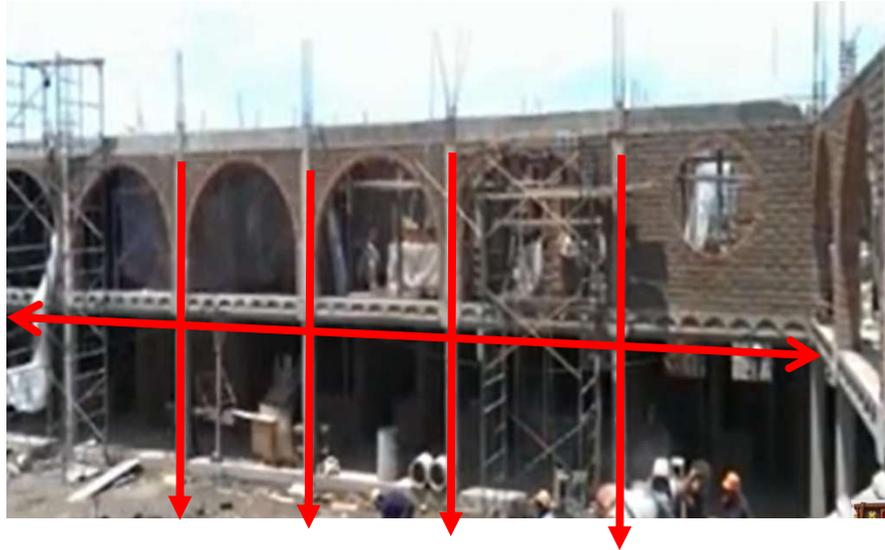
**Figura 69.** Estructura losa y columnas
