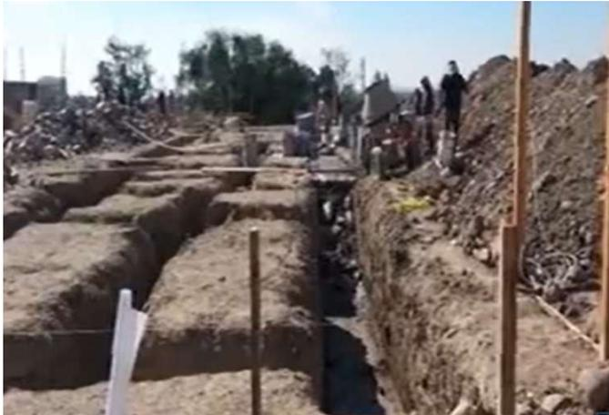
**Figura 67.** Excavación de cimientos.
