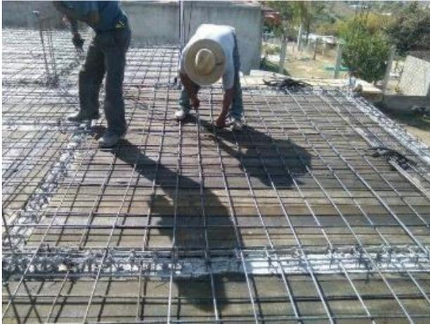
Figura 37. Armado de losa
