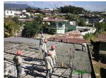
Figura 32. Fundición de losa tradicional
