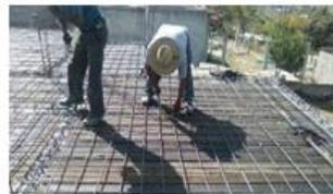
Figura 29. Armado de losa (1)
