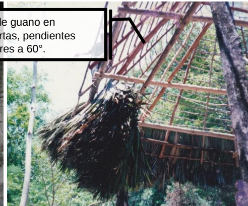
Figura 86: Ejemplo de sistema constructivo en San José, Petén. Foto de Proyecto Laj Ketz.
