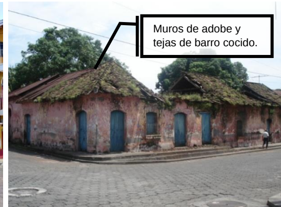
Figura 60: Ejemplo de materiales de construcción en La Democracia. Foto de Dafne Edith Domínguez.
