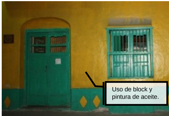
Figura 99: Ejemplo de sistema constructivo contemporáneo en Isla de Flores. Foto de Dafne Edith Domínguez.
