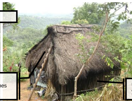
Figura 68: Ejemplo de materiales de construcción en Tanshá, Jocotán. Foto autor desconocido.
