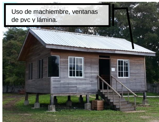
Figura 103: Ejemplo de sistema constructivo contemporáneo en Petén. Foto de Dafne Edith Domínguez.
