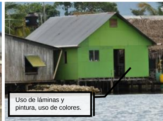
Figura 102: Ejemplo de sistema constructivo contemporáneo en Palafitos, Río Dulce. Foto de Jorge Fuentes.
