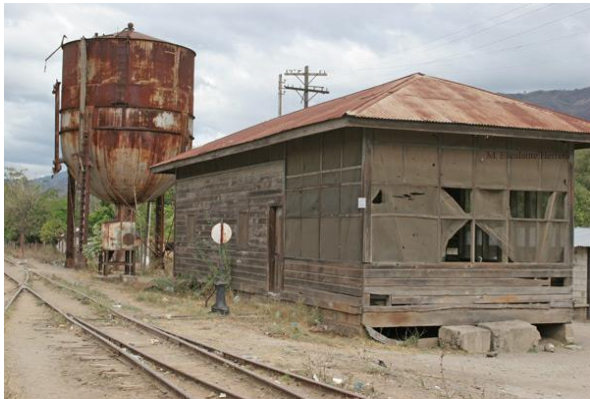
Figura 73: Ejemplo de sistema constructivo en San Cristóbal Acasaguastlán, El Progreso. Autor desconocido.
