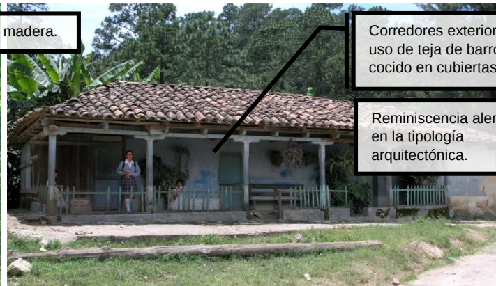
Figura 92: Ejemplo de sistema constructivo en Joyabaj, El Quiché. Foto de Lon&Queta.
