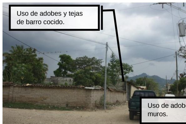
Figura 64: Ejemplo de materiales de construcción en Trifinio. Foto de Dafne Edith Domínguez.
