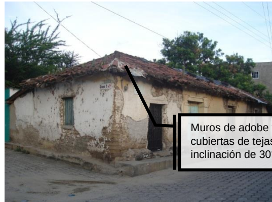
Figura 74: Ejemplo de sistema constructivo en Casa de Zacapa. Foto de Julia Vianey López.
