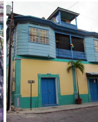
Figura 87: Ejemplo de sistema constructivo en Flores. Foto de José Contreras.
