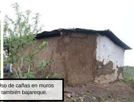
Figura 69: Ejemplo de materiales de construcción en vivienda de Camotán. Foto autor desconocido.
