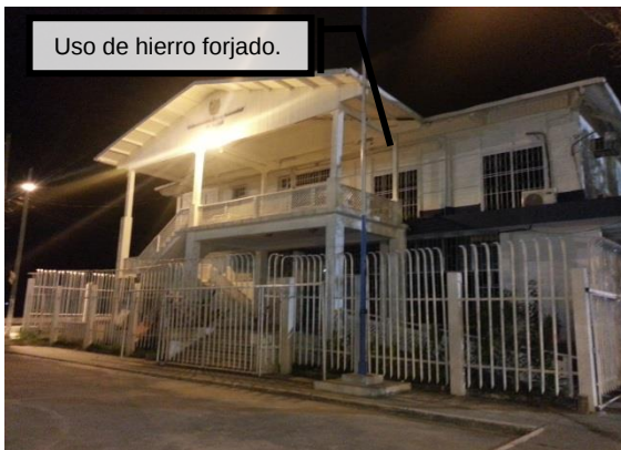
Figura 105: Ejemplo de sistema constructivo contemporáneo en Izabal. Foto de Dafne Edith Domínguez.
