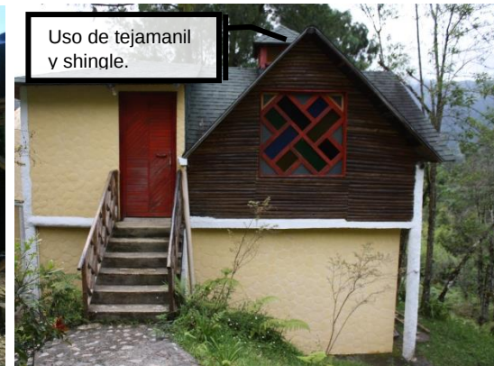
Figura 107: Ejemplo de sistema constructivo contemporáneo en Baja Verapaz. Foto de Dafne Edith Domínguez.
