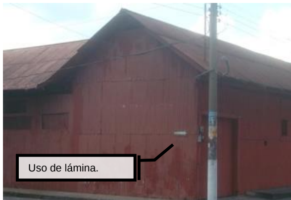
Figura 101: Ejemplo de sistema constructivo contemporáneo en Retalhuleu. Foto autor desconocido.
