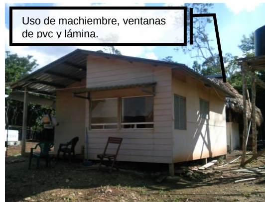
Figura 106: Ejemplo de sistema constructivo contemporáneo en Petén. Foto de Dafne Edith Domínguez.
