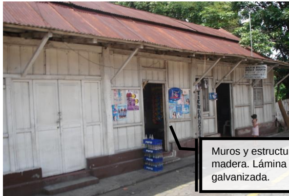
Figura 58: Ejemplo de sistema constructivo en La Democracia. Foto de Dafne Edith Domínguez.
