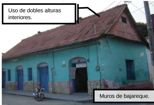
Figura 81: Ejemplo de sistema constructivo en la Isla de Flores, Petén. Foto de Dafne Edith Domínguez.
