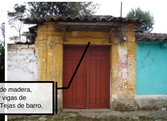
Figura 44: Ejemplos de materiales de construcción en casas típicas de San Marcos. Fotos de Julia Vianey López.
