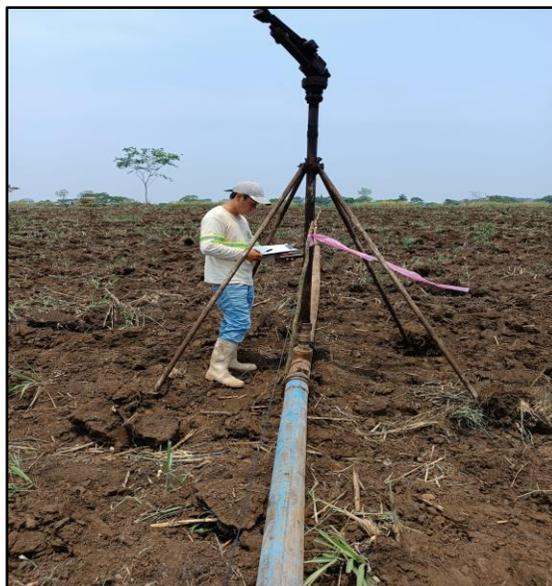
**Figura 8. Instalación de las válvulas de paso de 2 pulgadas para cada aspersor con su respectivo nylon de identificación.**
