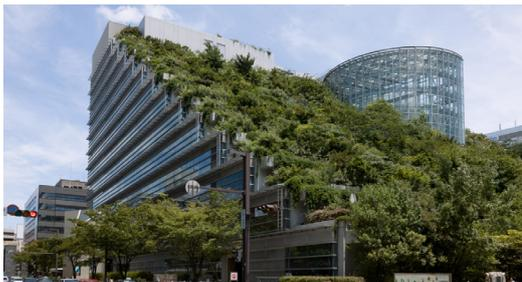
**Optimización de recursos naturales y artificiales:** Una serie escalonada de espejos de agua sobre las terrazas del ACROS Fukuoka están conectados mediante la pulverización de chorros de agua, para crear una cascada que enmascara el ruido ambiente de la ciudad.
