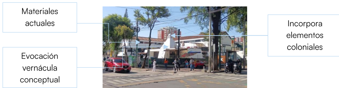
Figura 24 Foto hacia el “Centro Comercial La Cúpula” desde la 7va. avenida zona 9, tomada por Pablo Acajábón.
