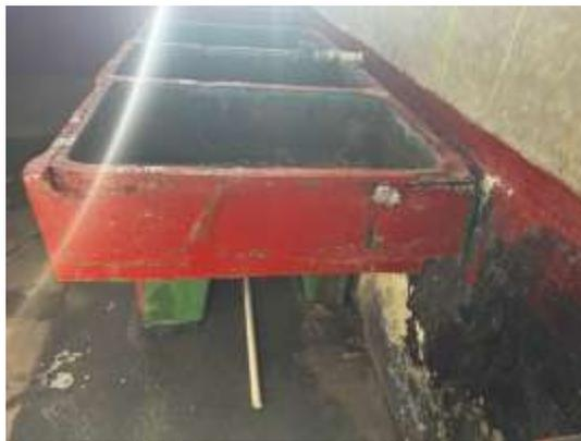
**Fotografía 2.** Pila en mal estado, se pueden observar las varillas oxidas.
