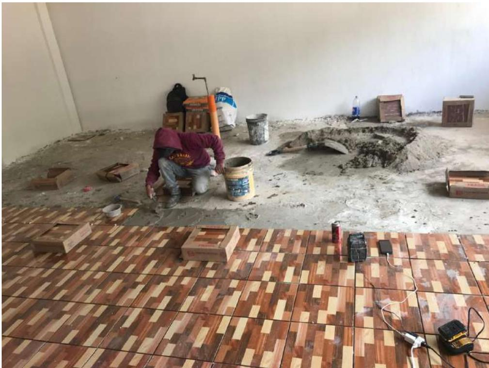
**Foto 4.** Colocación de piso de la ampliación de cocina.
