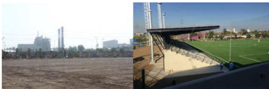
Figura 19. Fotografía del antes y después de la remodelación del Estadio Esparta 113
