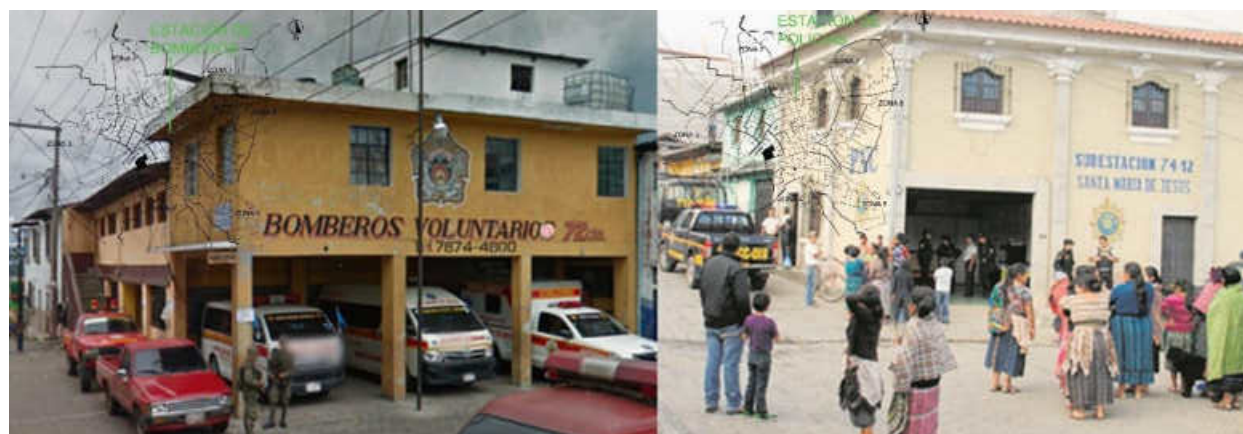
Figura 45. Bomberos voluntarios y Subestación de policías 155 156
