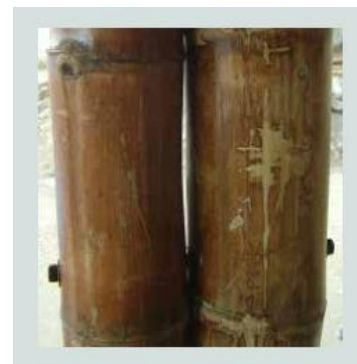
Figura 46 Pernos con 2 bambúes, (INBAR 2015)
