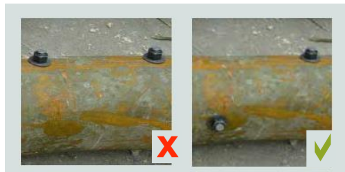
Figura 50 Uniones con pernos, (INBAR 2015)
