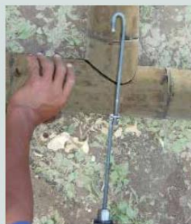
Figura 48 Uniones con pernos, (INBAR 2015)
