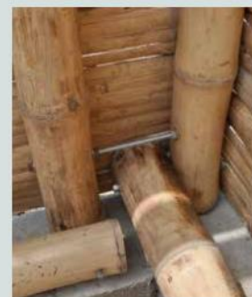
Figura 47 Uniones con pernos, (INBAR 2015)
