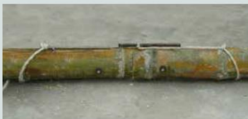
Figura 49 Uniones longitudinales, (INBAR 2015)
