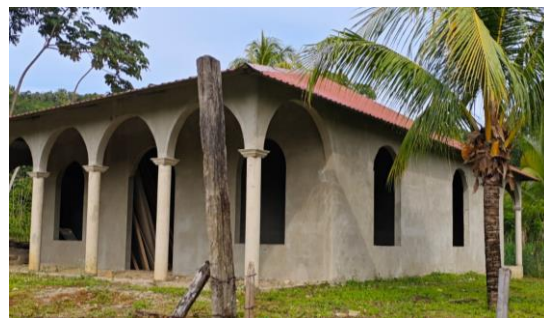
Figura 80 Construcción en proceso, (Kevin Rodriguez, 2024)
