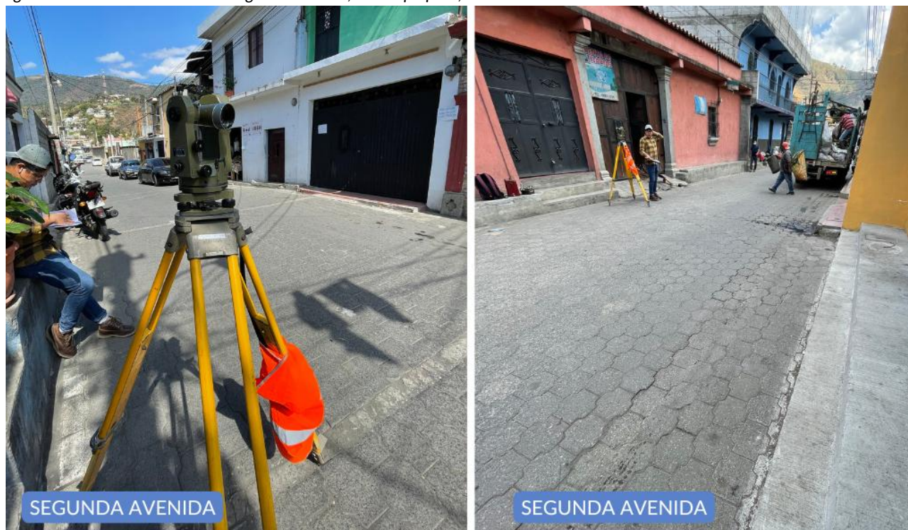
Figura 76. A la izquierda fotografía del equipo topográfico durante la medición y a la derecha proceso de traslado del equipo topográfico a la siguiente estación para determinar los vértices de la calle, 2021.
