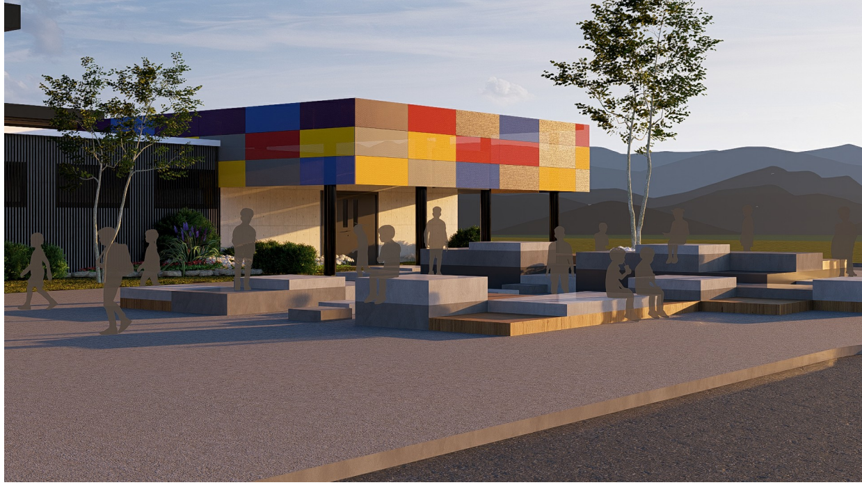
Vista Exterior 5 - SUM
