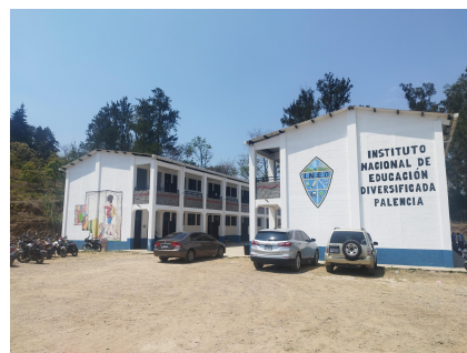
CONSTRUCCION EXISTENTE COLINDANTE CON EL TERRENO, TIENEN EL MISMO INGRESO VEHICULAR
