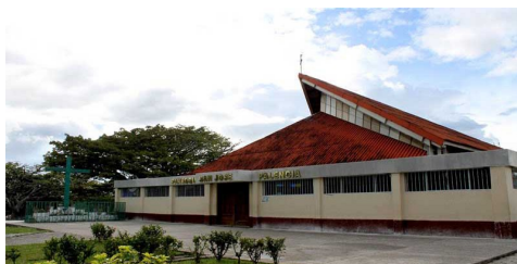
EDIFICIO RELIGIOSO QUE SE ENCUENTRA SOBRE LA CALLE PRINCIPAL CA9
