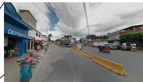
VISTA DESDE LA CARRETERA CA9, CARRETERA JACOB GUZMAN
