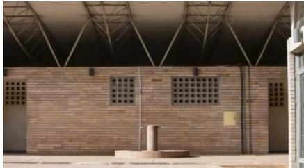
Figura 53: Cubierta flotante.
