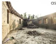
Utiliza paja para las cubiertas y bajareque para los muros
