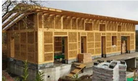
Figura 13: "Construcción de paja y tierra".
