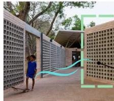
Utiliza módulo reticular en las celosías para mitigar la incidencia solar y permitir el ingreso de ventilación cruzada
