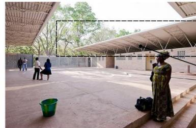
La estructura triangular de las cubiertas permite mayor ventilación al interior de los espacios. Además, proporciona una sensación de ligereza y modernidad a la edificación
