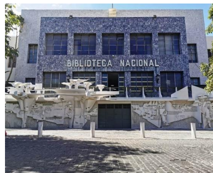
Figura 10 Fachada frontal de la Biblioteca Nacional de Guatemala
