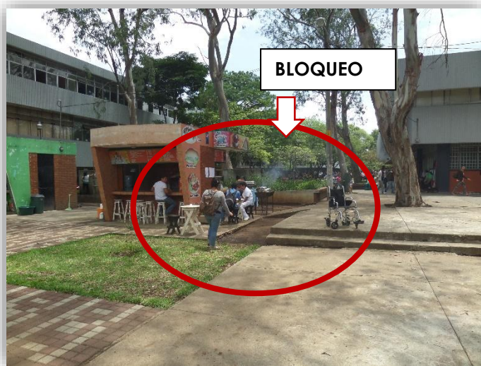
Capítulo 6 imagen 26 Rampa bloqueada completamente por negocio de comida, impide cualquier intento de utilización de la rampa.
