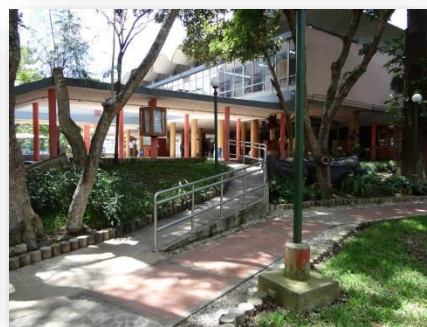
Capítulo 6 imagen 29 Rampa en el área de ingeniería, supera la pendiente máxima recomendada para una persona sin ayuda. Muy angosta y utiliza ángulos poco adecuados para una correcta circulación
