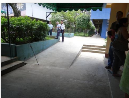
Capítulo 6 imagen 29 Rampa en el área de ingeniería, supera la pendiente máxima recomendada para una persona sin ayuda. Muy angosta y utiliza ángulos poco adecuados para una correcta circulación
