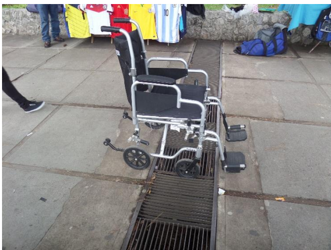
Capítulo 6 imagen 23 Muestra del problema existente en las reposaderas ubicadas a lo largo del polígono interior
