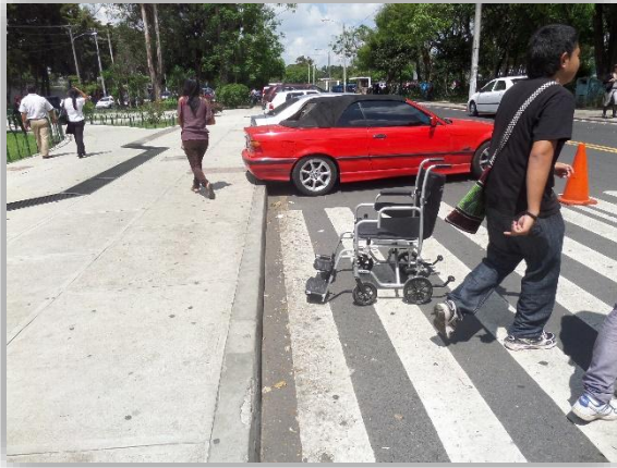
Capítulo 6 imagen 6 Problemas en las aceras
