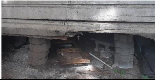
Pilotes de madera principales colapsados, de manera provisional, existen elementos que no son aptos para el soporte correcto del edificio.
