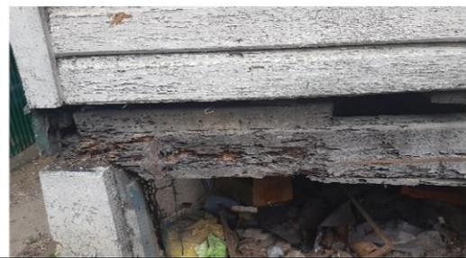
Vigas de soporte principales de madera, con evidente desintegración por depredación de agentes bióticos.
