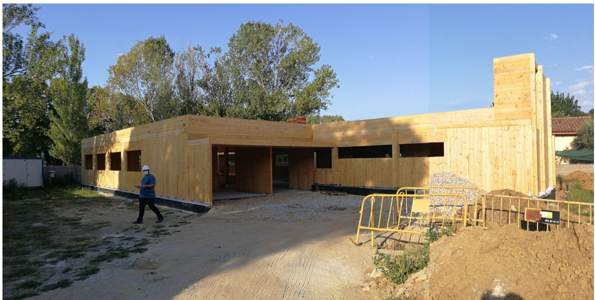
Figura 15 CAP de Riells i Viabrea, diseñado por Comas-Pont arquitectes (España 2021). Fotografía en Arch Daily, “CAP de Riells i Viabrea / Comas-Pont arquitectes”, https://www.archdaily.cl/cl/976452/cap-de-riells-i-viabrea-comas-pont-arquitectes/62029f2f44baf7016571b667-cap-de-riells-i-viabrea-comas-pont-arquitectes-foto
