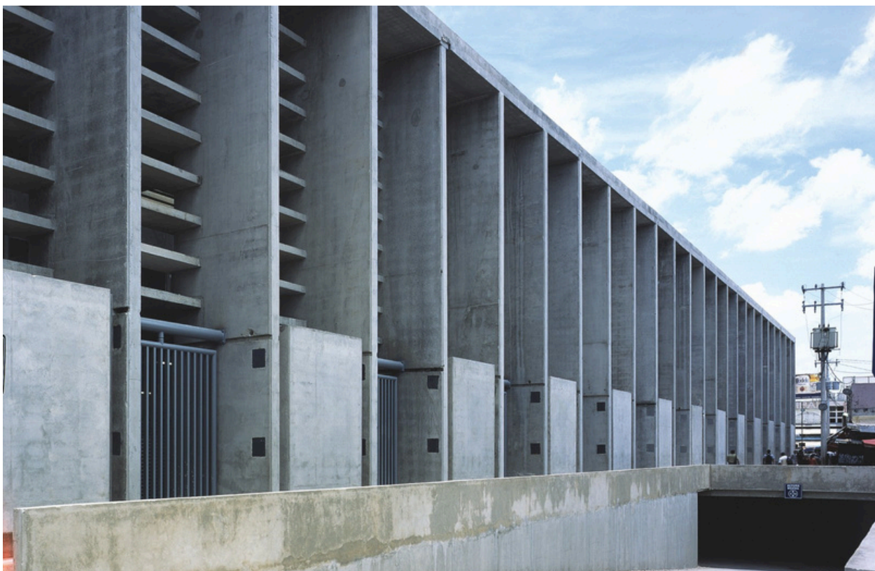
Figura No. 38. Fachada exterior mercado de San Benito.
