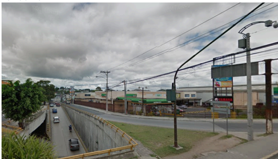
Figura No. 80. Paso a desnivel con dirección a San Rafael desde CA-9
