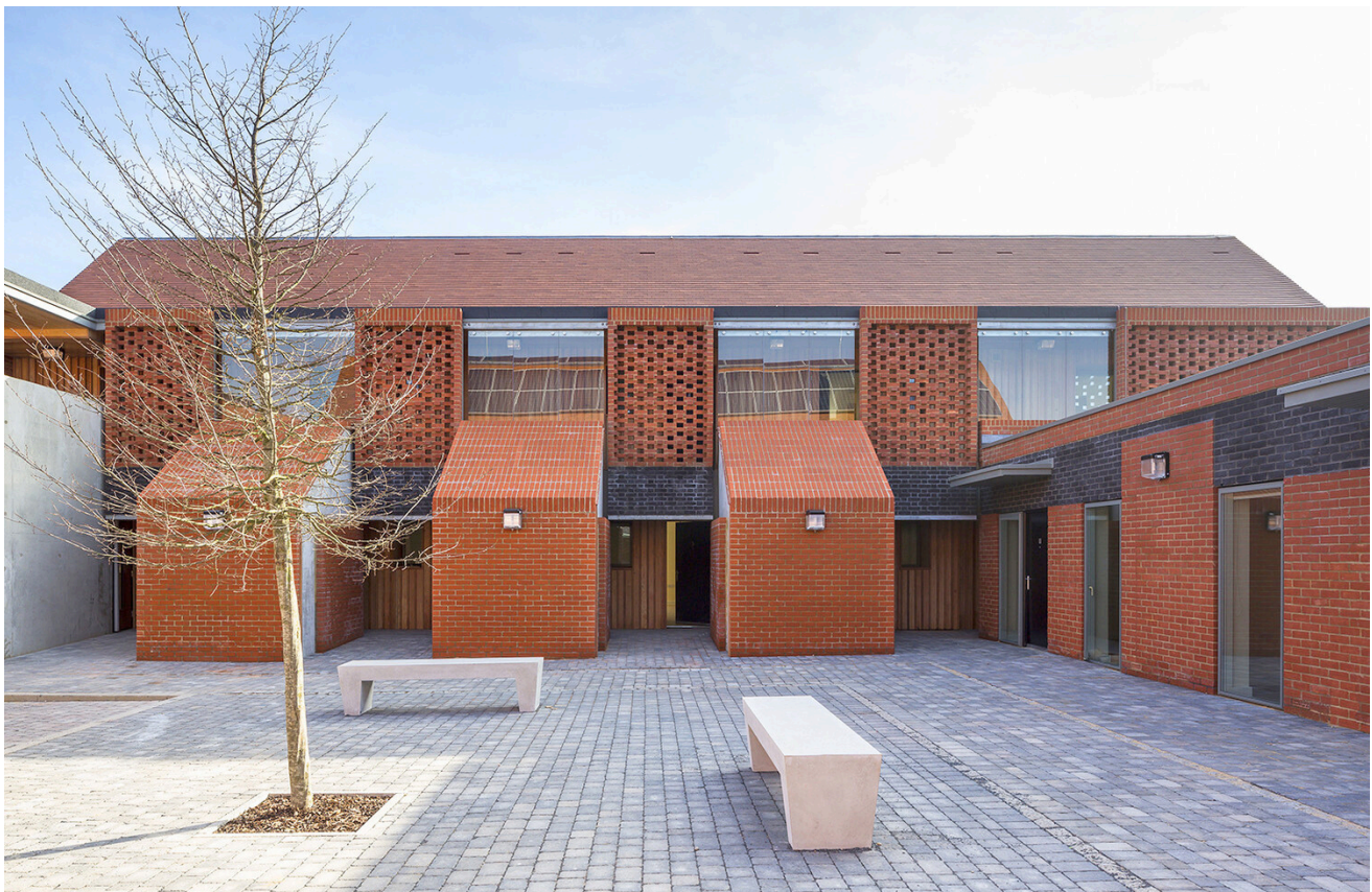
Figura 32. Viviendas Hargood Close Fuente: https://www.archdaily.cl . Junio 2024
