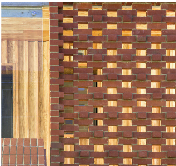
Figura 34. Viviendas Hargood Close Fuente: https://www.archdaily.cl . Junio 2024
