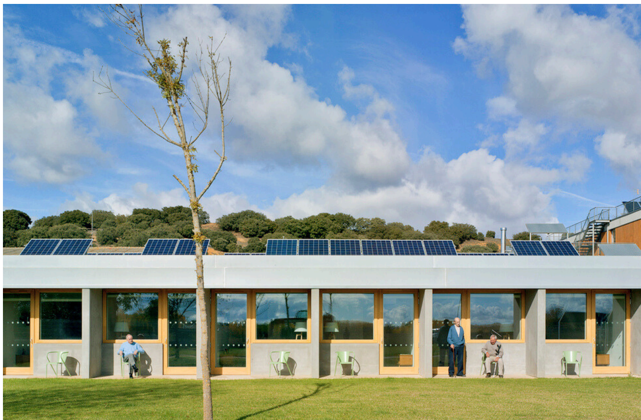
Figura 24. Residencia de Ancianos Passivhaus Fuente: https://www.archdaily.cl . Junio 2024
