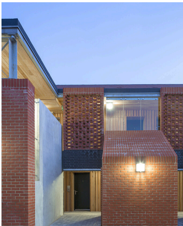
Figura 33. Viviendas Hargood Close Fuente: https://www.archdaily.cl . Junio 2024
