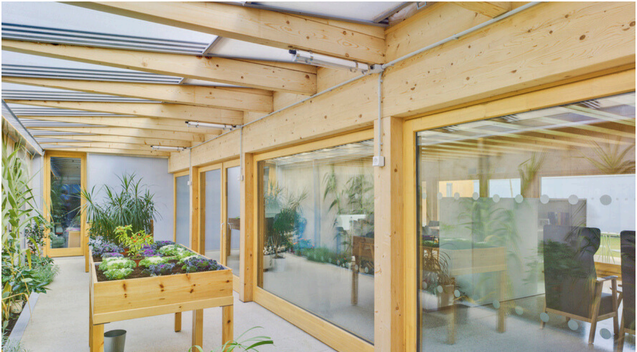
Figura 30. Residencia de ancianos Passivhaus Fuente: https://www.archdaily.cl . Junio 2024
