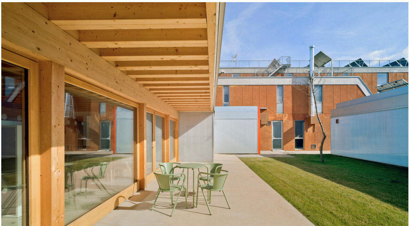
Figura 31. Residencia de ancianos Passivhaus Fuente: https://www.archdaily.cl . Junio 2024
