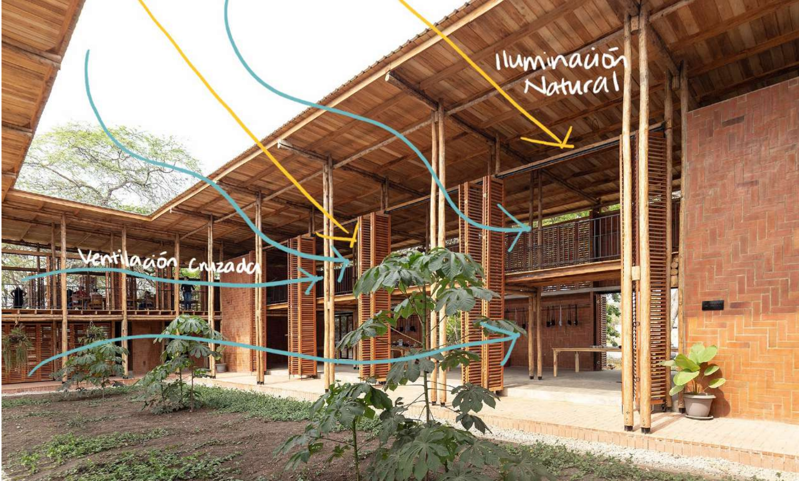
Figura 29. Patio interior del Centro Comunitario Las Tejedoras, JAG Studio, 2023, https://tinyurl.com/yj8csavr , con anotaciones propias.
