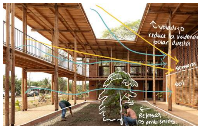
Figura 31. Patio interior del Centro Comunitario Las Tejedoras, JAG Studio, 2023, https://tinyurl.com/yj8csavr , con anotaciones propias.
