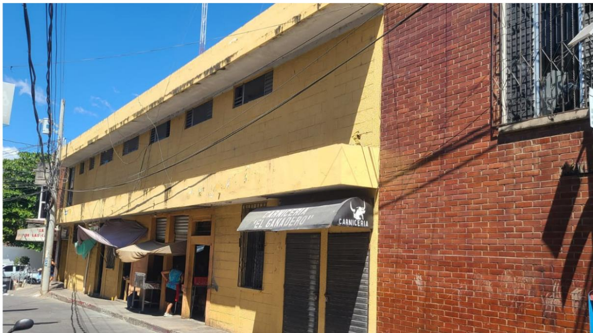
Imagen 11: Fotografía fachada principal Fuente: imagen propia
