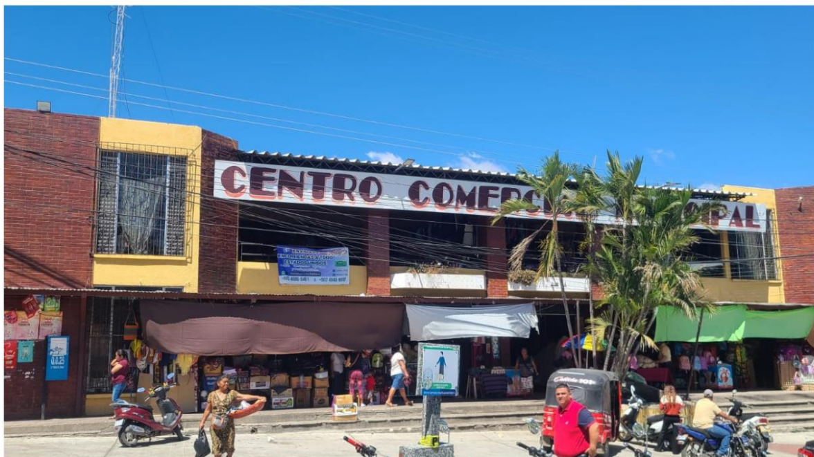
Imagen 10: Fotografía fachada principal Fuente: imagen propia
