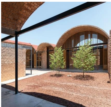
Figura 15: Obra Bernardo Gómez Centro comunitario Ruiz
