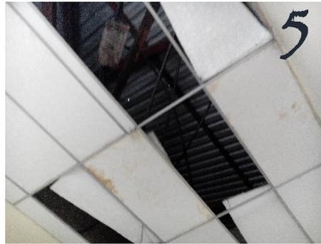
**Ilustración 24** Cielo falso en malas condiciones, en todo el edificio, elaboración propia.
