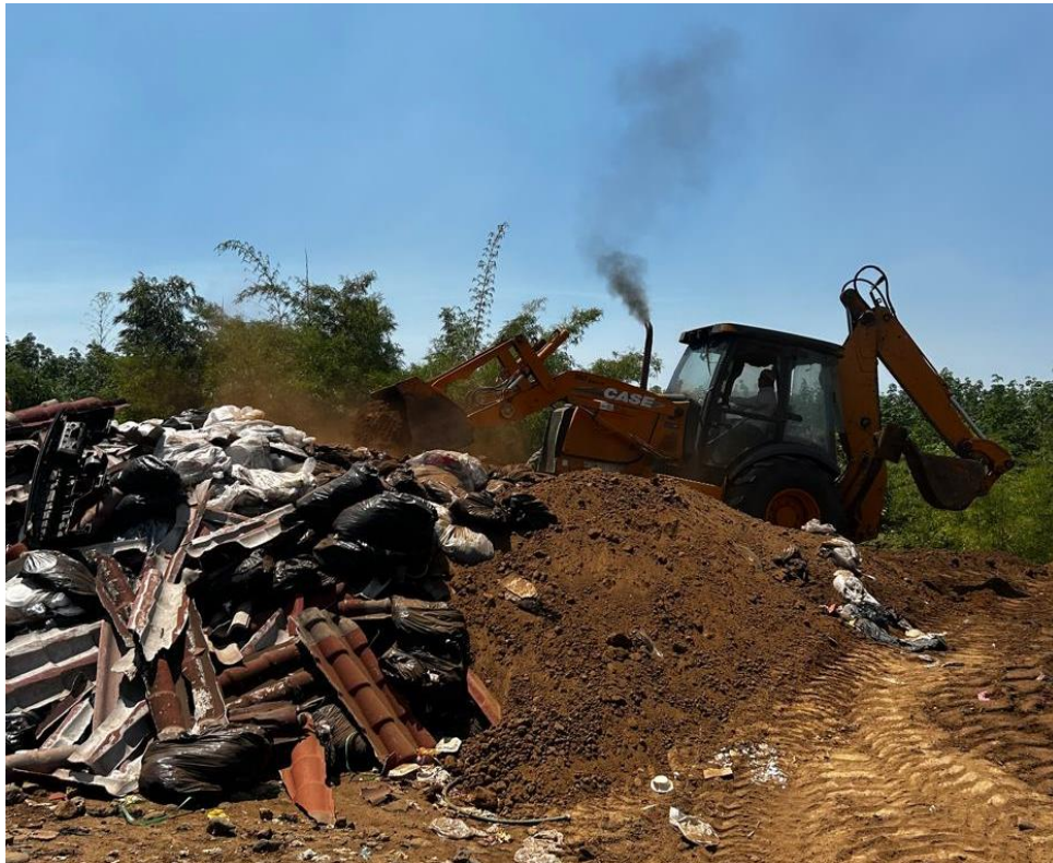
Figura 70 Proceso de recubrimiento con tierra de los desechos no recuperables.
