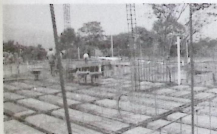
Sangando para la cimentación del edificio, después de la nivelación Enero, 1,998.
