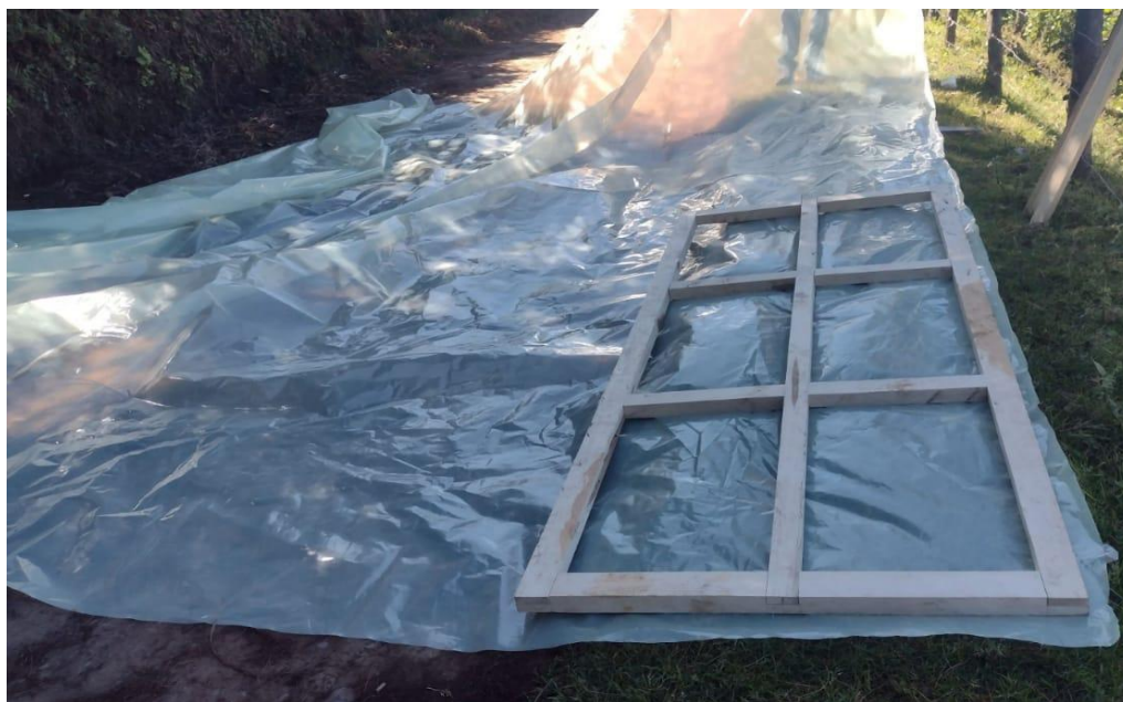
Figura 27: Colocación de nylon para la puerta del invernadero no. 2
