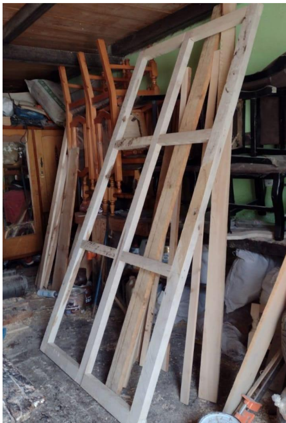
Figura 26: Elaboración de Puerta para el Invernadero No.2
