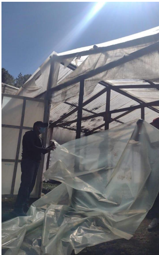
Figura 28: Cambio de Nylon del invernadero No.2
