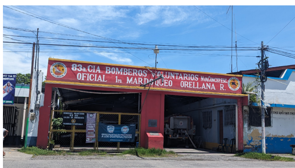
Figura 41: Estación de bomberos.
