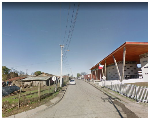
Figura 24: Vista hacia Avenida Bueras.
