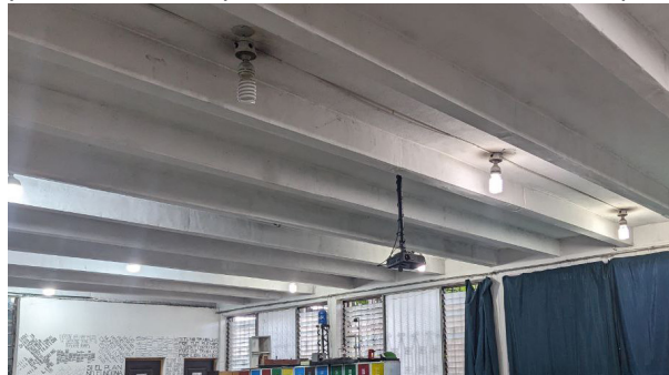
Figura 12: Vigas de Concreto Reforzado
