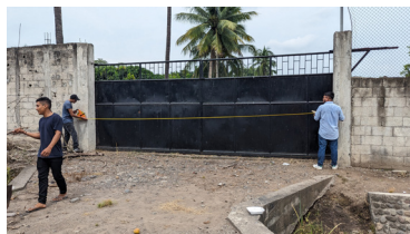
Figura 49: Acceso actual del terreno con portón metálico con un ancho de 7 metros.
