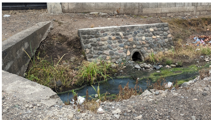
Figura 38: Cuneta existente en terreno.
