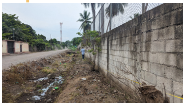
Figura 50: Cuneta para drenaje de agua pluvial
