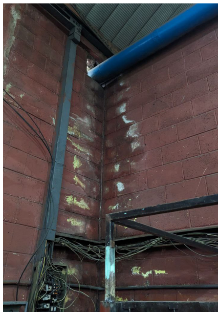
Figura 16: Filtraciones pluviales.
