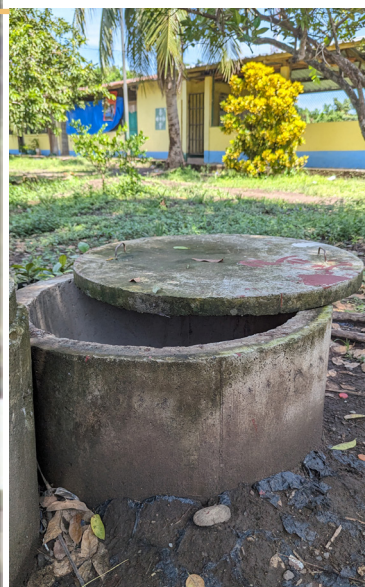
Figura 55: Pozo existente, sin uso actualmente, la caliad del mismo es deficiente.
