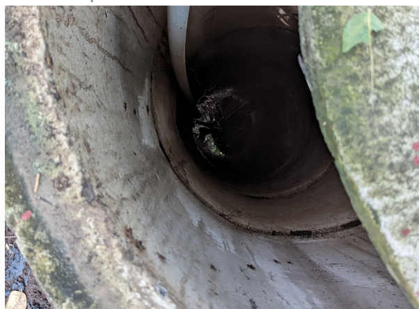
Figura 37: Pozo existente en terreno.
