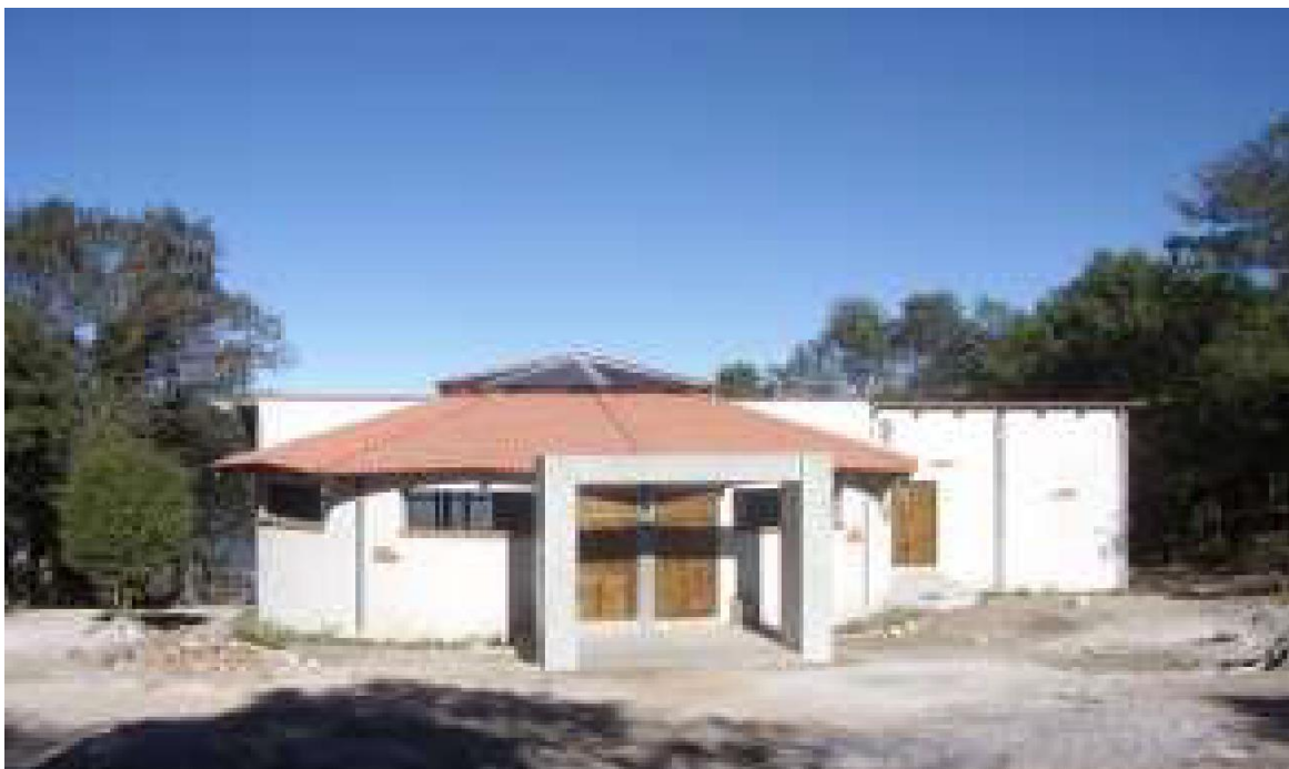
Figura 14. Salón de usos múltiples del centro turístico Cacique Dormido” (k’um k’um Wutz). Fuente. Diagnóstico Integral Municipal/ equipo de facilitadores 2009, (Pág. 61) Oficina Municipal de Planificación.
