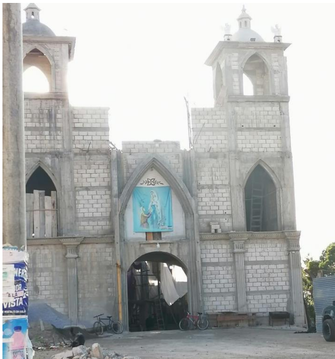
Figura 9. Construcción Iglesia Las Flores
