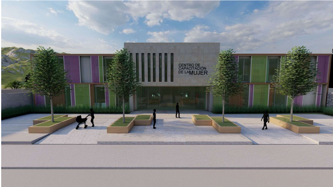
FIGURA 92. FACHADA PRINCIPAL Elaboración Propia
