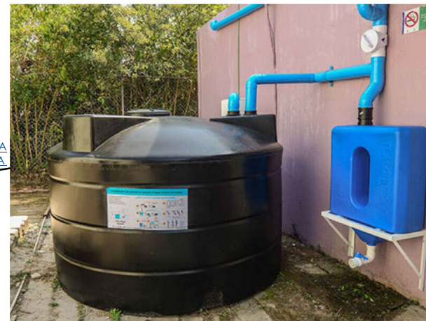
Figura No. 71: Sistema recolector de agua de lluvia. Fuente: https://www.construex.gt
