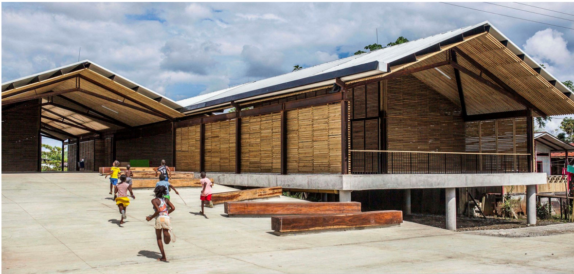
Figura No. 8: Parque educativo saberes ancestrales, Vigía del fuerte, Colombia: Arquitectura Social. Fuente: https://images.adsttc.com/media/images/5744/153f/e58e/ce1e/dd00/0159/slideshow/05_Rampa.jpg?1464079664
