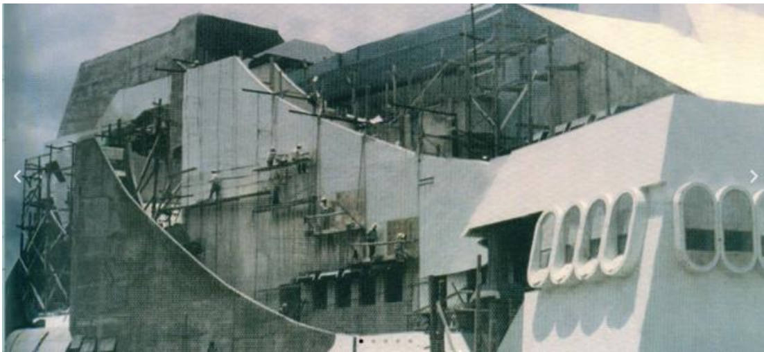
Figura 38 Colocación de teselas
