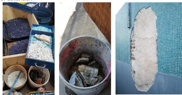
Figura 39 Restauración de teselas
