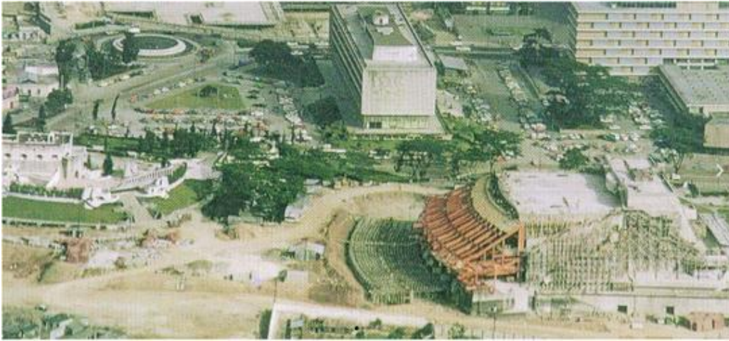
Figura 37 Imagen de la construcción del teatro nacional
